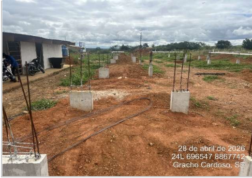
Execução de fundações Esc., Forma, Armação, Concretagem e Reaterro
