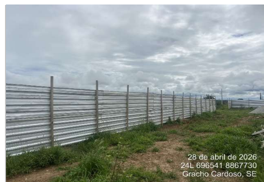
Fechamento da obra Utilização de telha metálica
