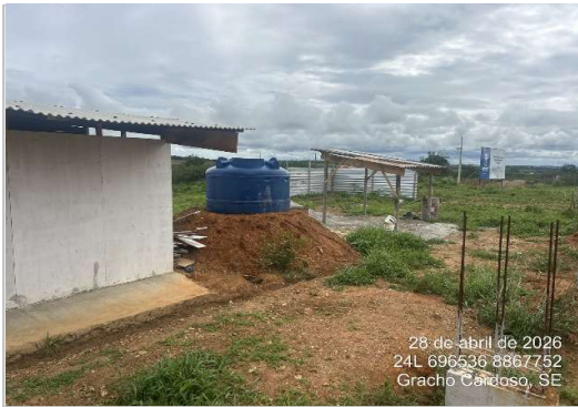
Área de betoneira e reservatório Canteiro
