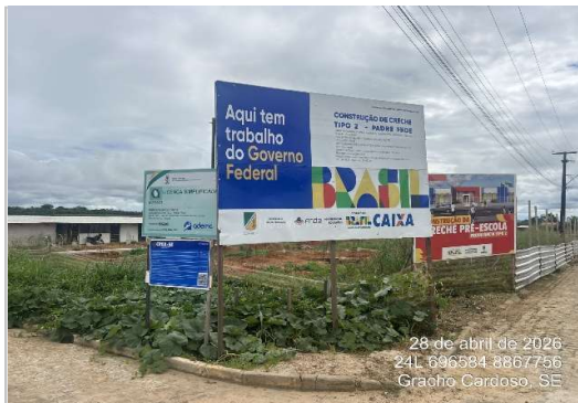
Placas de Obra instaladas Placa da ADEMA, CREA, OBRA
